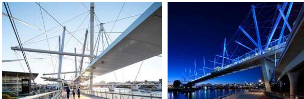
Fig.2,3 Cel mai mare pod tensegrity din lume "Kurilpa Bridge- Brisbane" [3]
